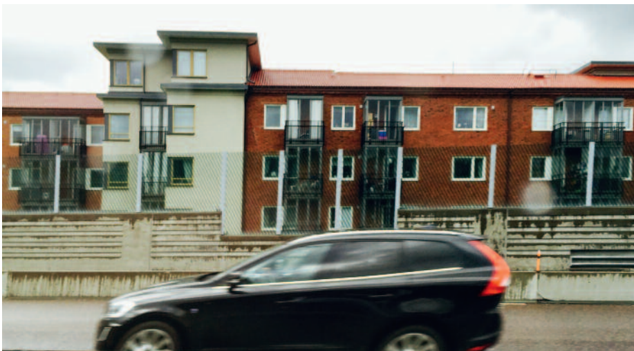
Bild 2: Partillestudien, med bullerskärm och komplementbebyggelse mellan huskropparna. Vy från E20 (östergående körfält) mot norr.
